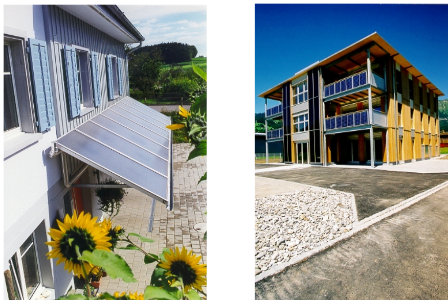
Figura 4: A sinistra, 14.4 m 2 di collettori solari integrati in facciata [SSES, Autore: Heizplan AG, 9450 Altstätten]. A destra, 61 m 2 di collettori solari integrati in facciata [SSES, Autore: Schibli Peter, Heizplan AG, 9473 Gams].
